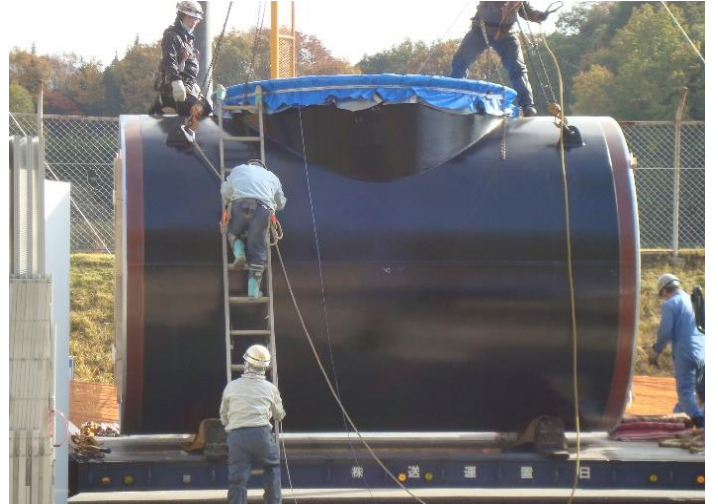
↑現場に吊りおろし準備です
