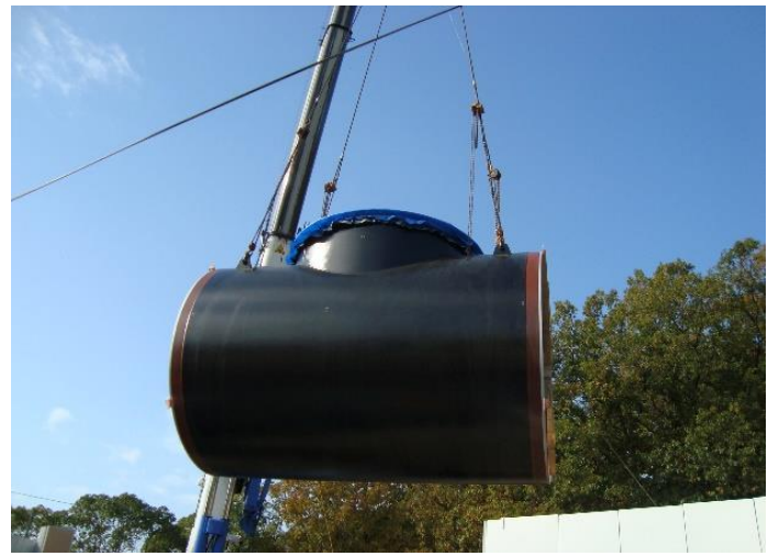
↑60t級のクレーンで吊りおろしです
