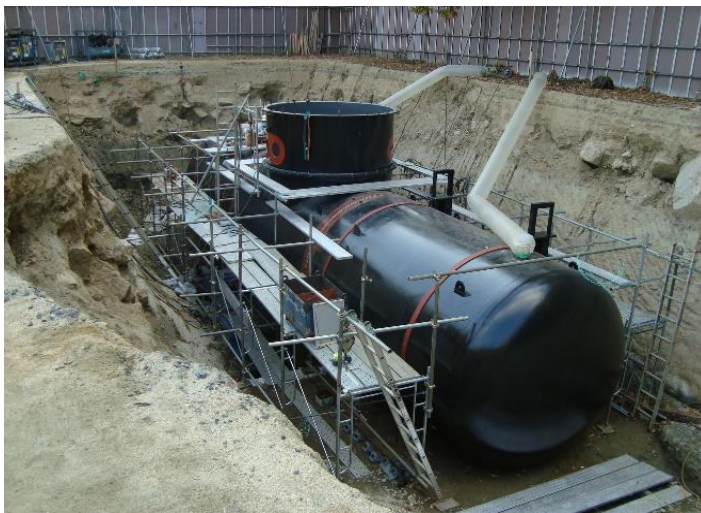
↑埋設場所に設置されました 深さ約5.5mの地下に埋設されます
