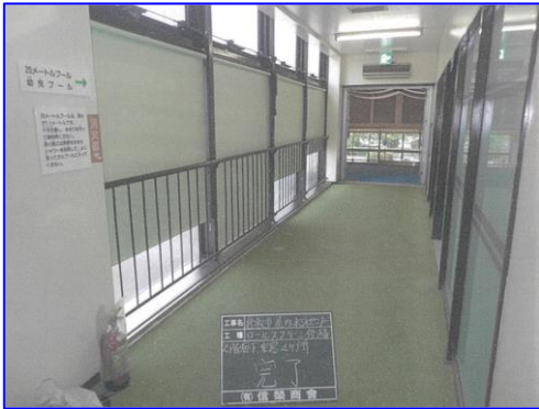
【水泳場通路へのロールスクリーン設置・同場所結露水排水改修】
