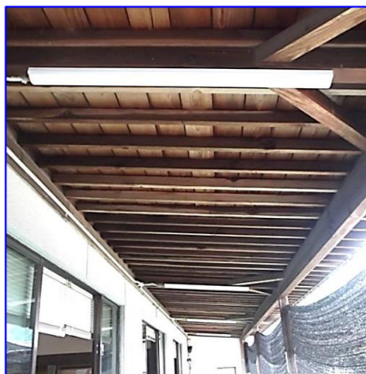
【弓道場通路照明LED化①】
