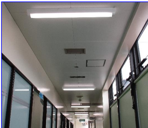
【水泳場通路照明LED化】
