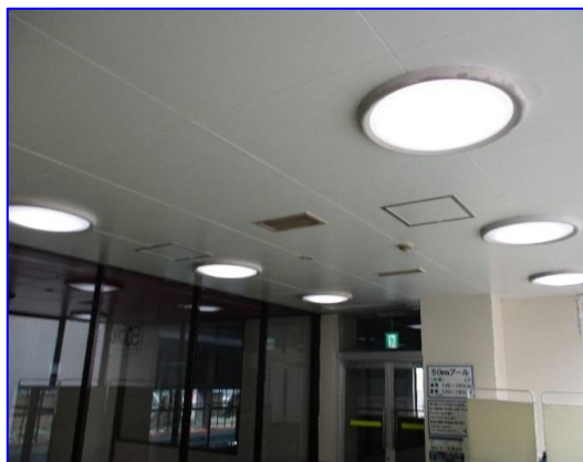
【水泳場通路照明LED化】
