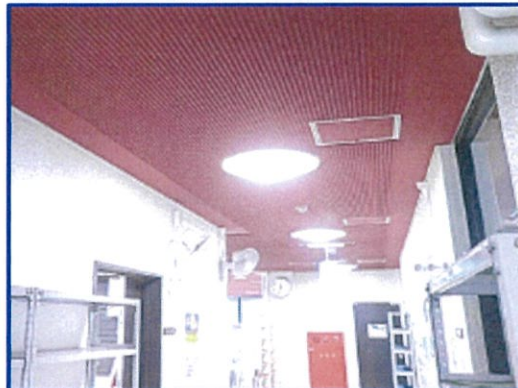
【水泳場廊下照明LED化】
