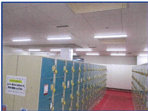
【水泳場更衣室照明LED化】
