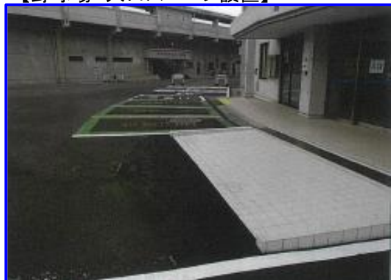
【野球場 入口スロープ設置】
