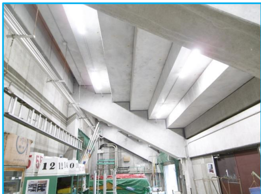
【照明LED化(陸上倉庫)】
