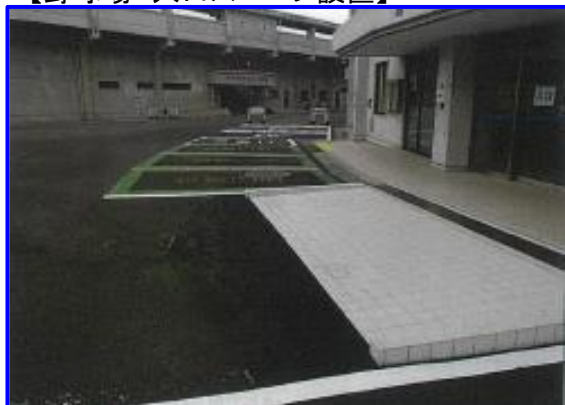
【野球場 入口スロープ設置】
