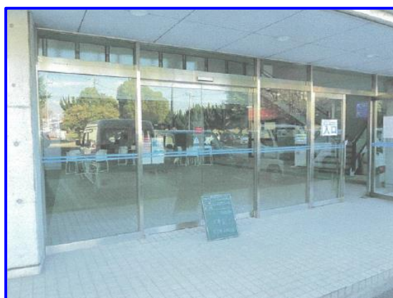
【野球場 ロビー扉自動設置】
